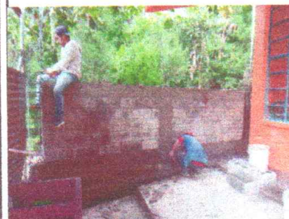
Foto 5: Reparación de muro perimetral
