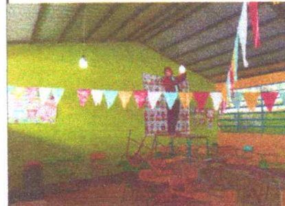
Foto 6: Reparación de cableado eléctrico
