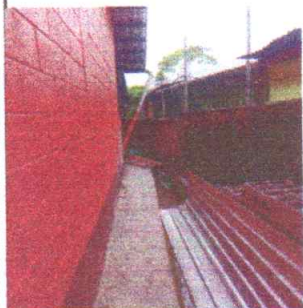
Foto 3: Reparación de muro perimetral
