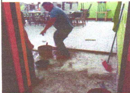
Foto 2: Sustitución de piso por piso de granito
