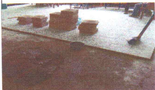
Foto 1: Sustitución de piso por piso de granito
